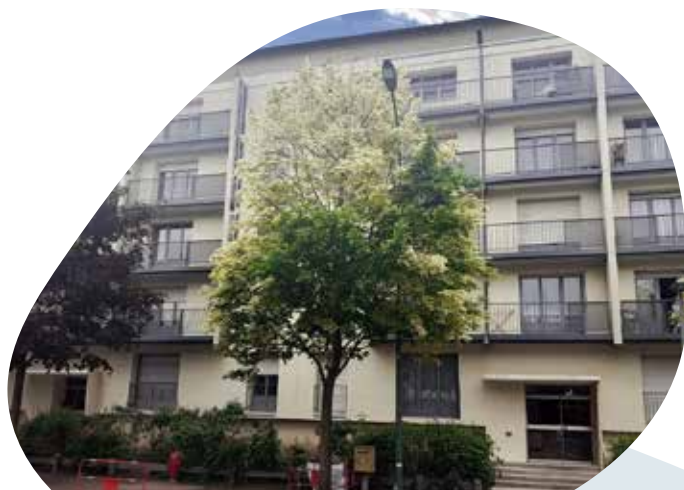
Vendôme – Avenue Gérard Yvon Renforcement des balcons - 1.018.421 € TTC
