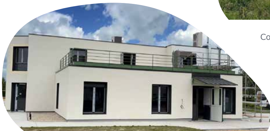
Bracieux - Bâtiment 84 Réhabilitation d'un tiers-lieux, micro-crèche et 5 logements inclusifs 1.100.000 € TTC
