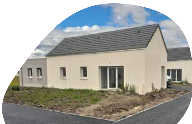
Cormeray – Clos de Mareau Construction de 9 pavillons - 1.800.000 € TTC
