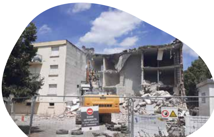
Langon – Centre Ville Démolition de 12 logements - 240.000 € TTC
