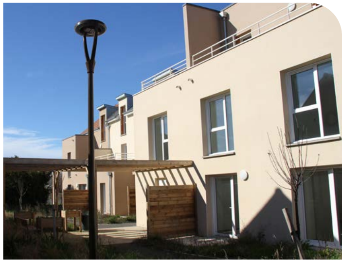
Les Patios Montais à Mont-près-Chambord 11 pavillons et 27 appartements 4.638.000 €TTC
