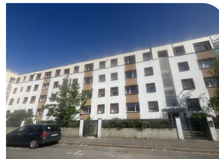
Blois – Avenue de France 104 logements
